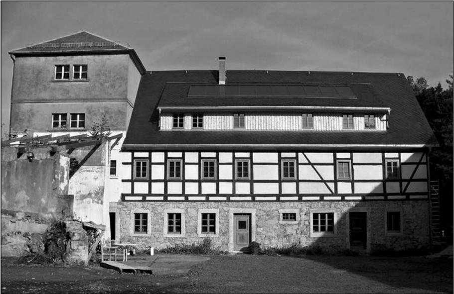
*Zustand heute (Aufnahme von 2014): Die Eingangstür ist wieder eingebracht, das Fachwerk aufgearbeitet und die Fenster sind erneuert. An die Stelle einer zwischenzeitlichen Bitumenschindeldeckung trat schöner blauer Schiefer und das überputzte Fachwerk wurde freigelegt. – Bildquelle: Barbara Kroll*
