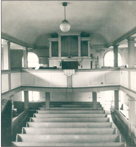
Abbildung 17: Gesamtansicht des Kirchensaales in Richtung Norden, Aufnahme 1987 (denkmalpflegerische Zielstellung)
