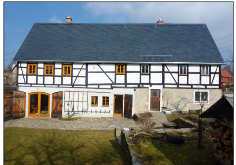
Abbildung 25: Die linke (westliche) Gebäudeseite zeigt sich im Frühjahr 2019 frisch saniert.
