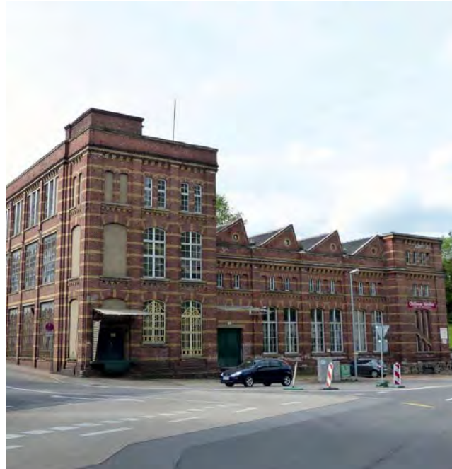
Süddansicht mit Neubau
