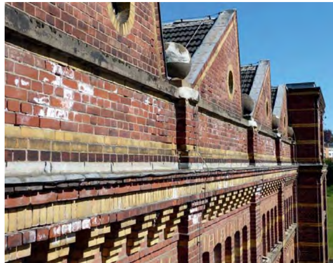
Das reich gegliederte Gesims der Sheddachhalle
