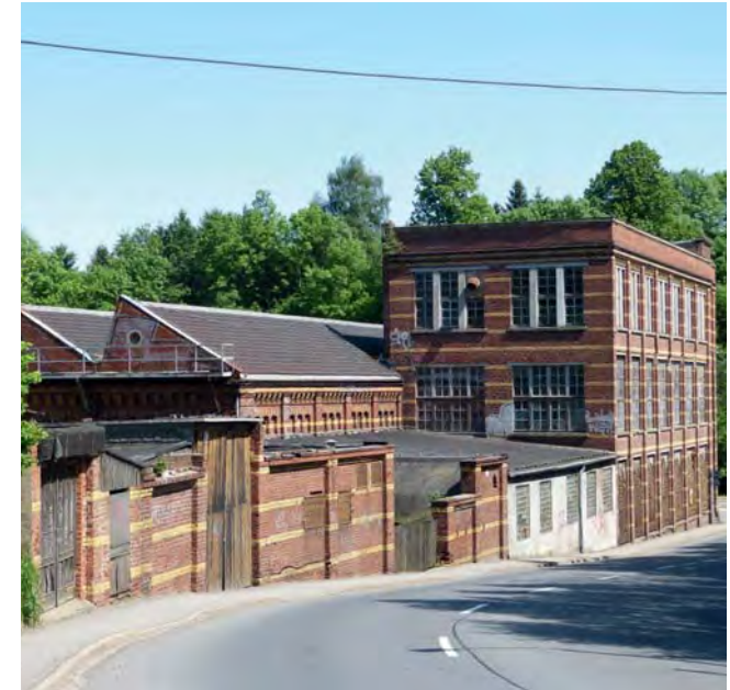
Blick von der Heinrich-Heine-Straße auf die Gebäude hinter dem Neubau
