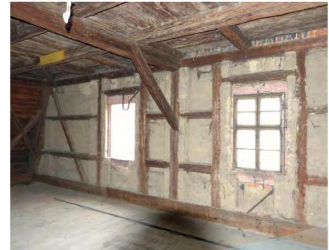
Innenansicht des massiv verkleideten Fachwerkgiebels der Ostseite mit Fenster (rechts) der Bauzeit (Abb. 3)
