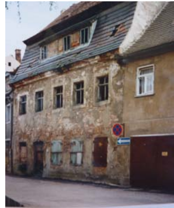
Letzte Erinnerung an das ehemalige Barockgebäude Badergasse 3 – Leerstand bereits gegen Ende der 1980er Jahre, abgerissen 1995.
