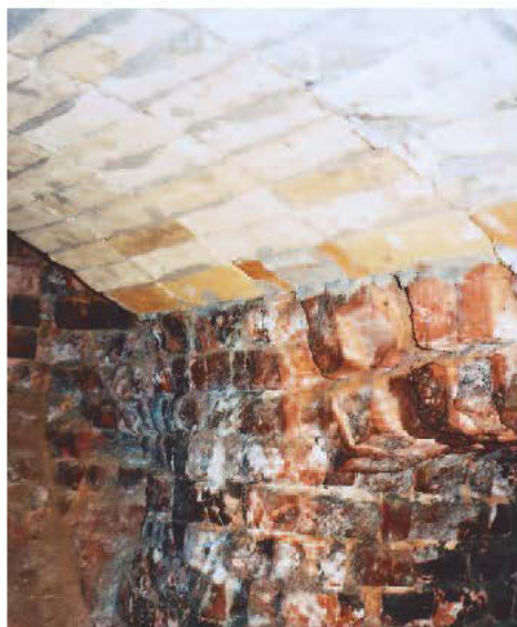
Das teilsanierte Kesselraumgewölbe 2007.
