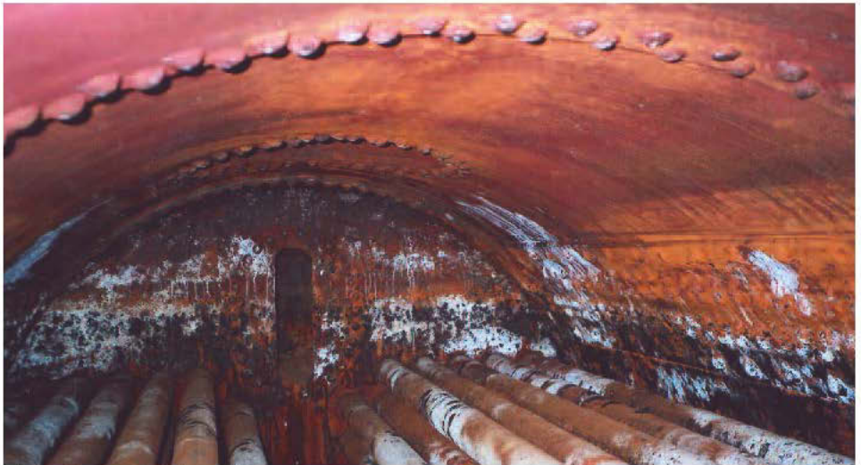
Blick in den Rauchrohrkessel, Zustand 2007.
