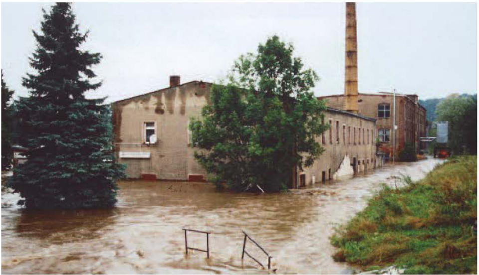
Maschinengebäude am 13. August 2002 während des Hochwassers 2002.
