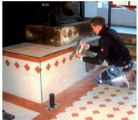
Historische Fliesen im Dampfmaschinenraum
