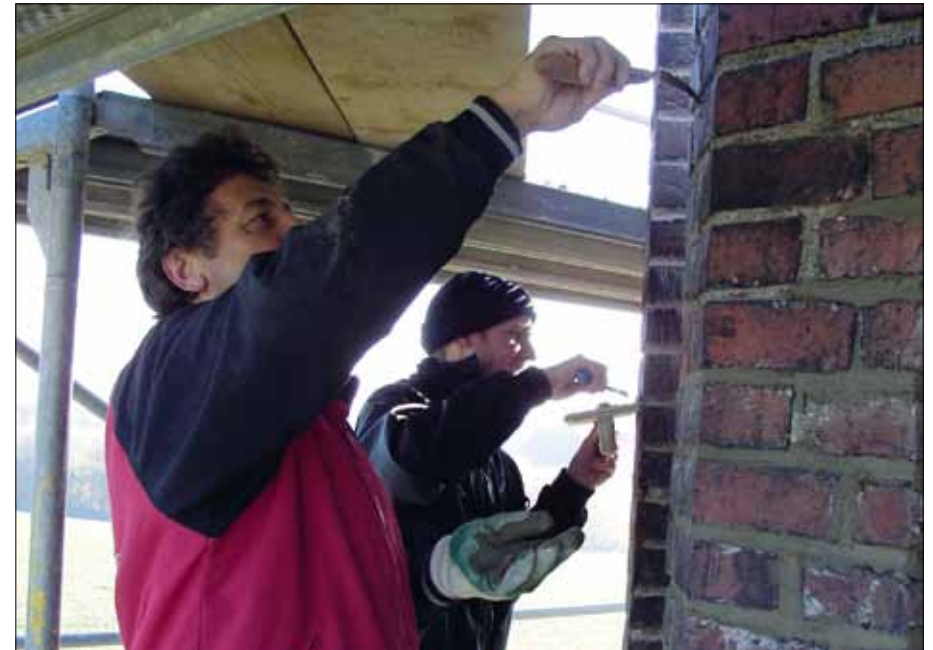
Beim Verfugen der Klinkerfassade
