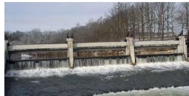
Die sanierte Wehranlage Flöha-Plau im Jahr 2009
