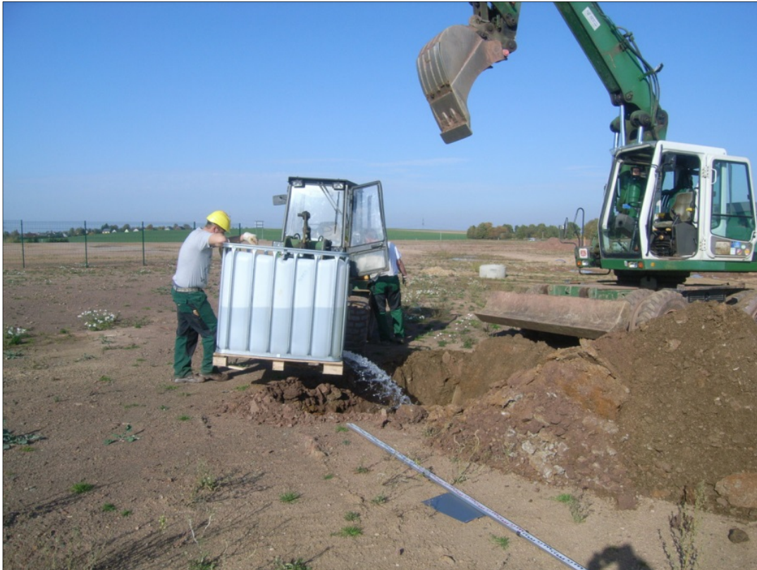
Bild 3: Beispiel für das Befüllen einer Schurfgrube
